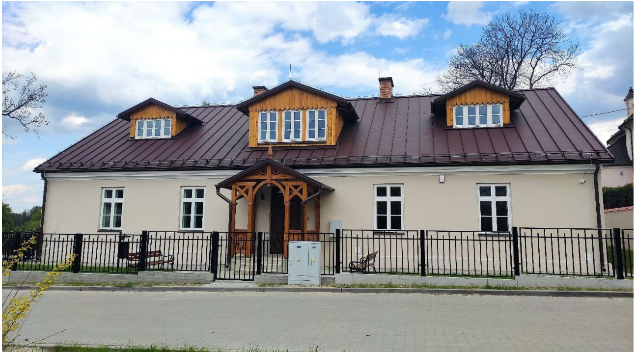
Nowa siedziba Gminnego Centrum Kultury
